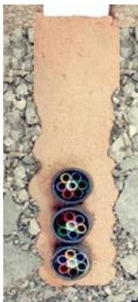
**Figura 8 - Esempio di colorazione del conglomerato cementizio**
