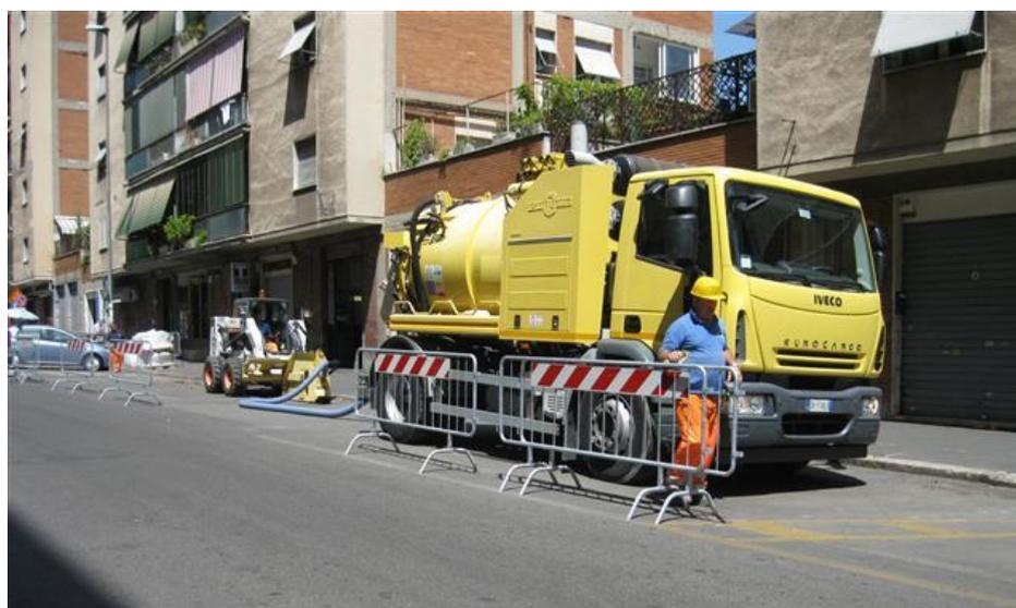
**Figura 13 - Ingombro dell'area di cantiere nella fase di scavo e di aspirazione**
