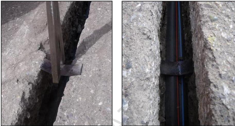
Figura 16 - Esempio di fissaggio dell'infrastruttura al fondo della minitrincea ridotta
