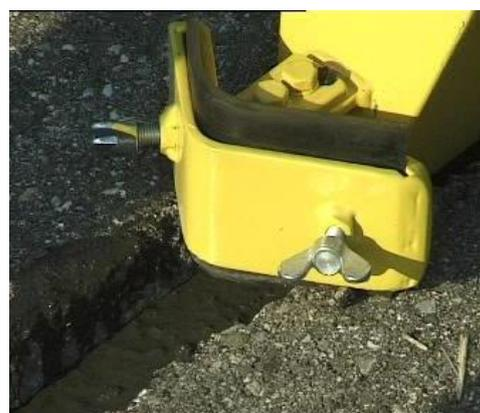
**Figura 14 - Esempio di macchina miscelatrice e riempimento della minitrincea**
