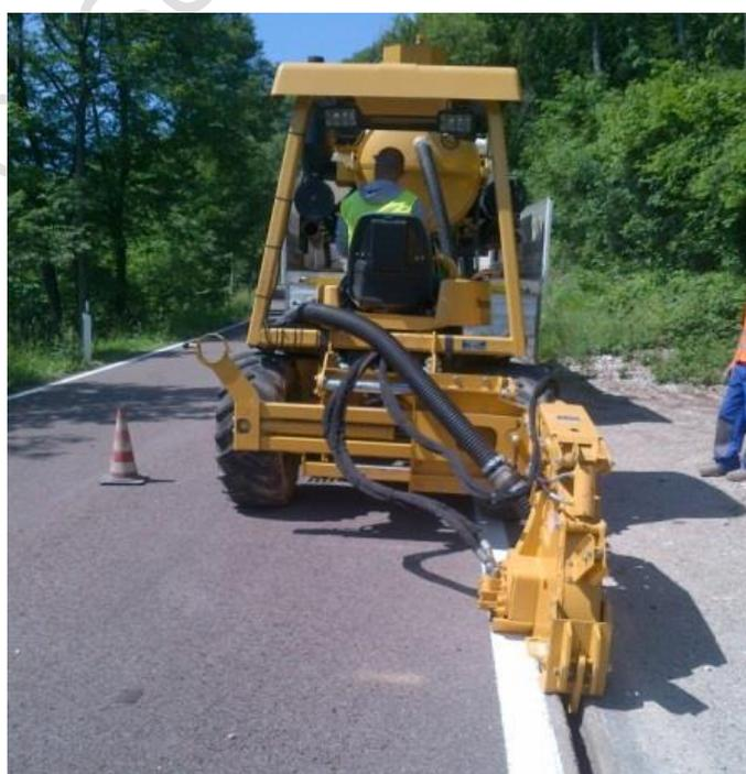
Figura 15 - Esecuzione dello scavo e pulizia della minitrincea
