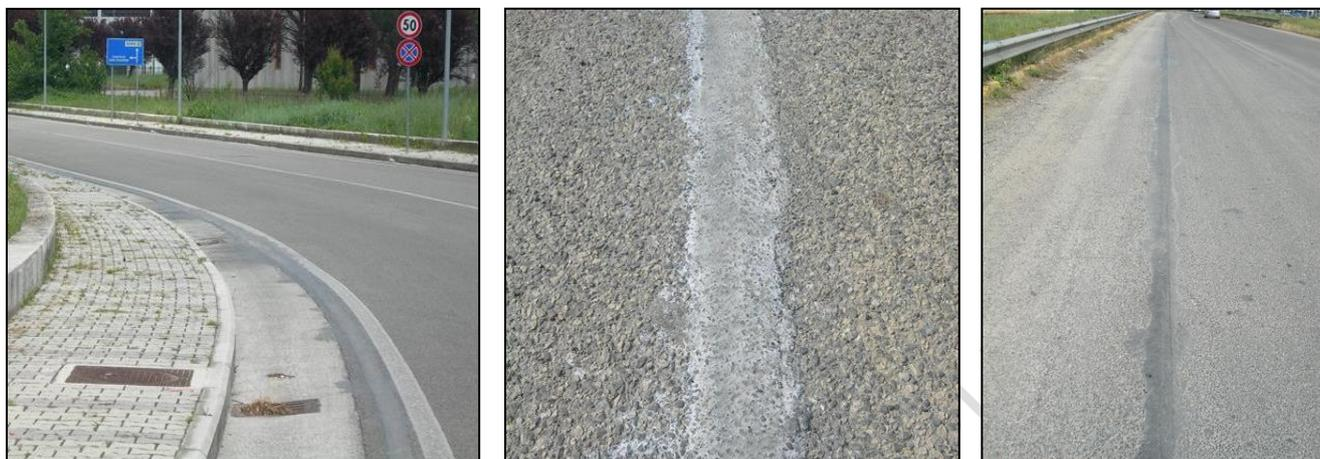
Figura 17 - Esempi di minitrincea ridotta finita
