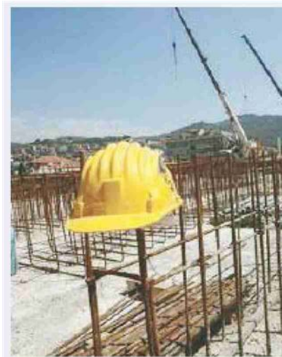
Un cantiere di lavoro
