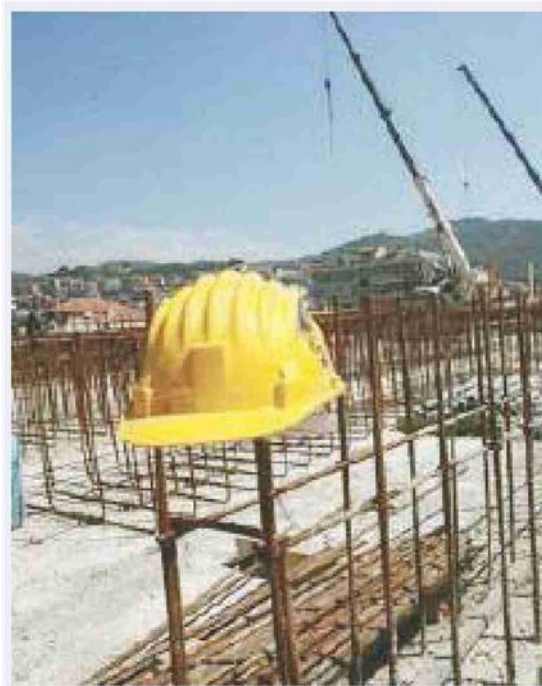
Un cantiere di lavoro
