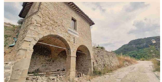
A otto anni dal sisma. A sinistra, interno di una casa di Accumoli in attesa di essere demolita. Sotto, ad Arquata del Tronto, un dettaglio dell'Ufficio per il turismo
