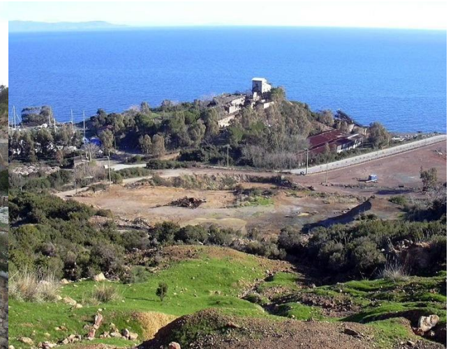
Complesso minerario di Vigneria, Rio Marina
