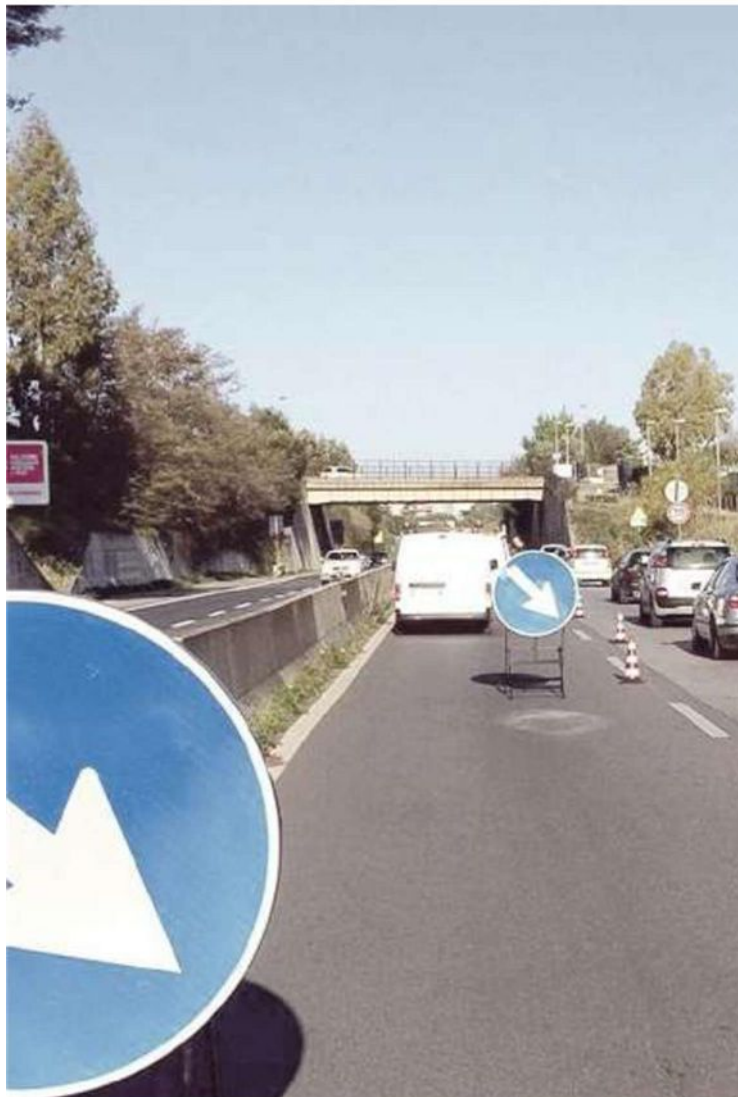
Un cantiere sulla Pontina
