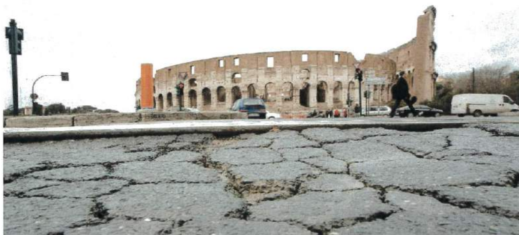
Un'immagine del degrado del manto stradale di Roma davanti al Colosseo
