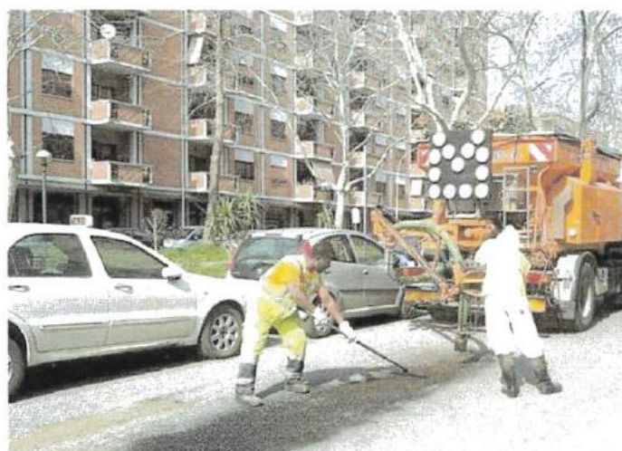
Un cantiere | I lavori stradali infiniti fra le lamentele delle imprese
