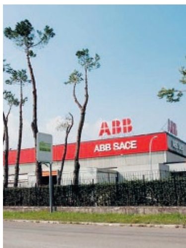
Lo stabilimento ABB di Frosinone
